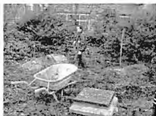
Foto: Jan van Oort stort het fundament voor een veilige plaatsing van de kerstboom.
