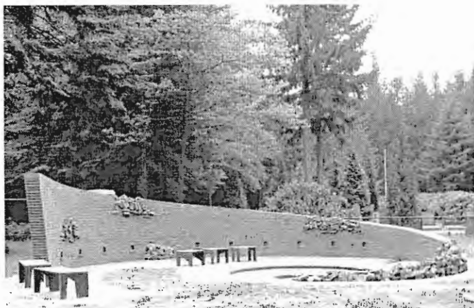
De Keerkring in aanbouw
