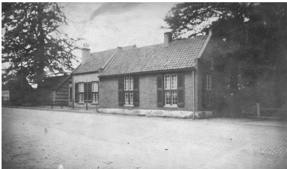
Het Tolhuis aan de Wolfhezerweg waar de wolf op zaterdagmorgen isesignaleerd. Rechts (nog net zichtbaar) de slagboom naar de Wolfhezerweg. Het is een eenvoudige woning waarvan het dak niet beschoten is, de sneeuw komt door de pannen heen. Het lichtere gedeelte links is in 1916 aangebouwd voor boswachter/tolgaarder Van Beek.
