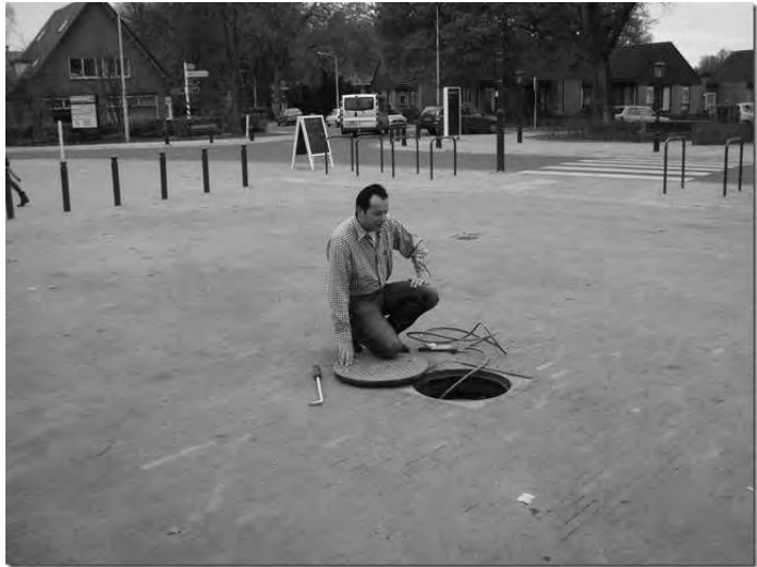
Inspectie van de put voor de stam van de den
