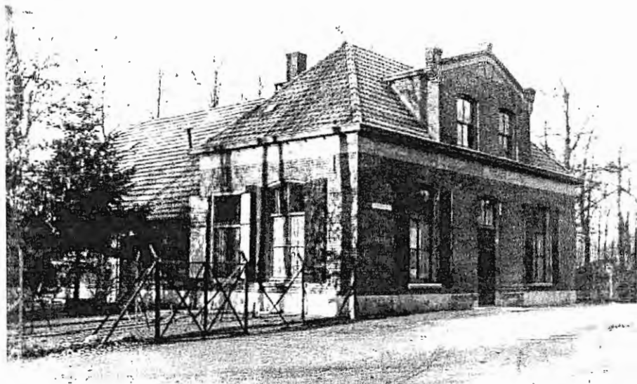
Op deze foto van 8 december 1933 is goed te zien hoe groot de ontginningsboerderij (toen in gebruik als directieket) wel was. De paardenstallen erachter zijn ook goed zichtbaar. Deze foto staat in een album dat de geschiedenis van de bouw van de Kliniek Neder-Veluwe beschrijft én illustreert. Dit album is in bezit van het Historisch Museum Wolfheze (conservator Cees Boersma).
