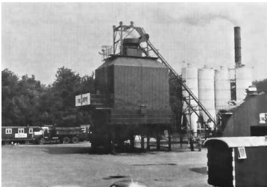
Foto uit 1971 met de Asfaltinstallatie AMMAN 1000 SB van het merk Te Sleppe met een asfaltvoorraadsilo van 4 x 100 ton. Deze stond ten zuiden van het dorp op het reeds afgegraven tracé van de weg.
