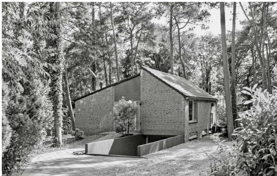
Een stenen bungalow op 't Hazeleger die nog in de originele staat is.
